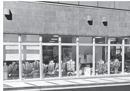
道路沿いは全面ガラス張りで採光よし
